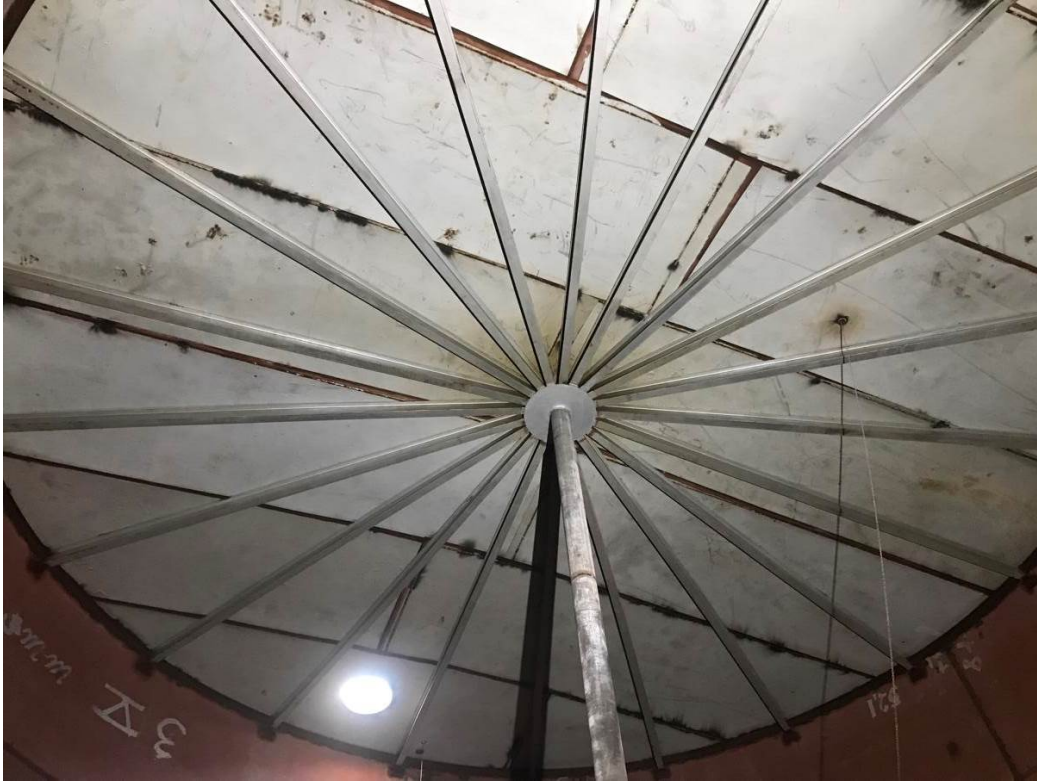
Mynd 1. Þak geymis
