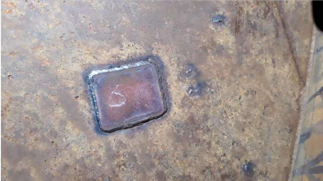
Mynd 7. Bæði voru settar litlar bætur yfir pyttasvæði og einnig soðið í staka pytti.
