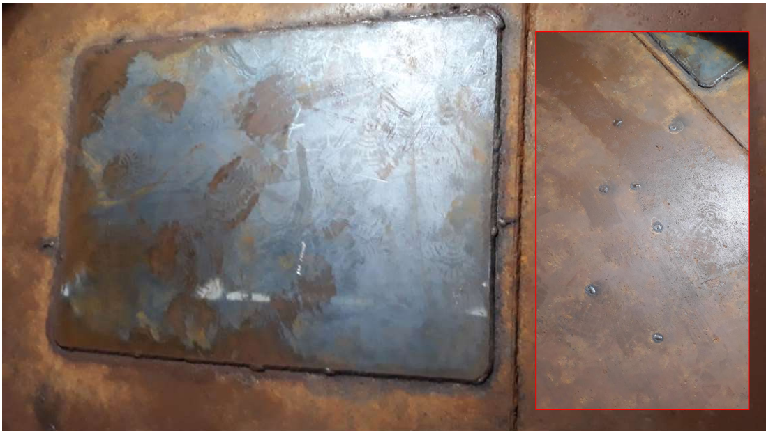
Mynd 8. Setja þurfti einnig eina stóra bót. Sjá einnig mynd af rafsúðustrengjum í plötu.
